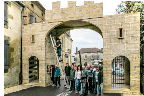
La porte lors de sa construction pour le Festival 2014
