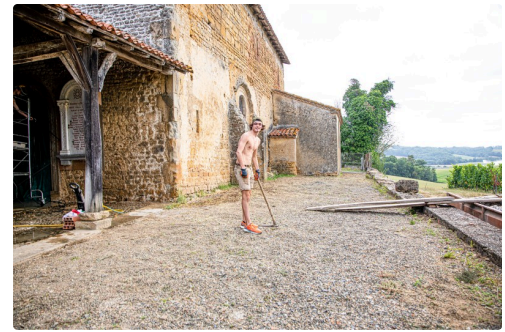
Ils ont débroussaillé cette surface
