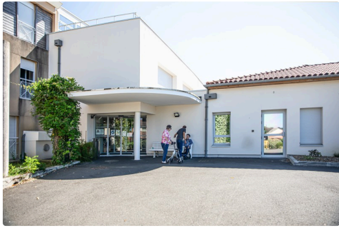
Entrée principale actuelle de l'hôpital de Nogaro
