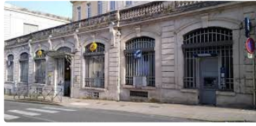
Le bureau de La Poste rue Gambetta en travaux
