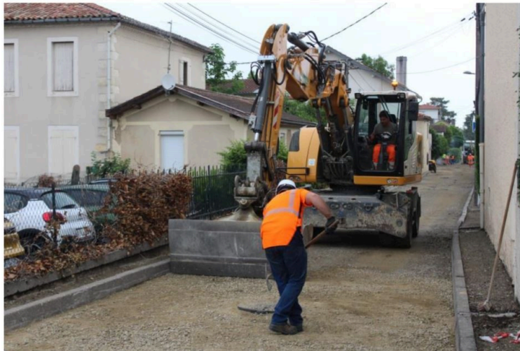
Travaux rue de Colmar
