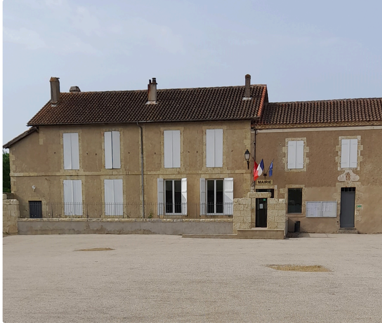
Centre du village de Caillavet : des travaux d'envergure !
