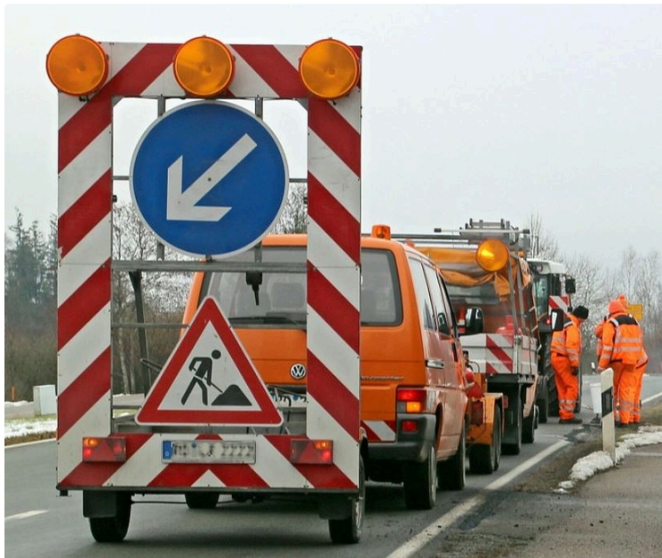
RN 124 : renouvellement chaussée
