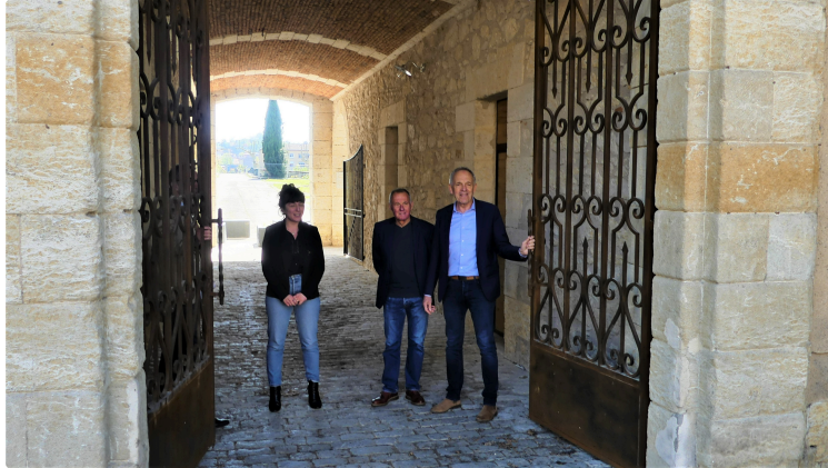
Ouverture de la caserne Espagne avec à terme 2 hectares rendus à la nature
