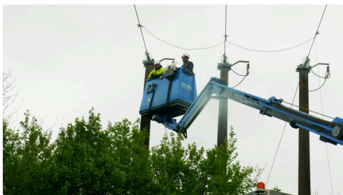
les techniciens en haut de la nacelle
