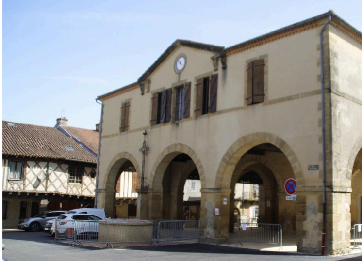
Revitalisation du centre bourg de Miélan : Report du chantier de grenaillage.
