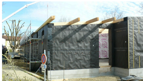
Travaux en cours.
