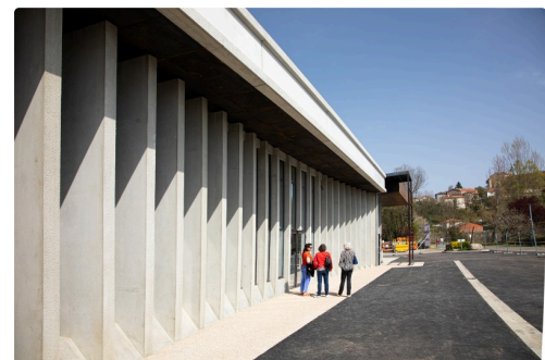
Façade du nouveau chai expérimental
