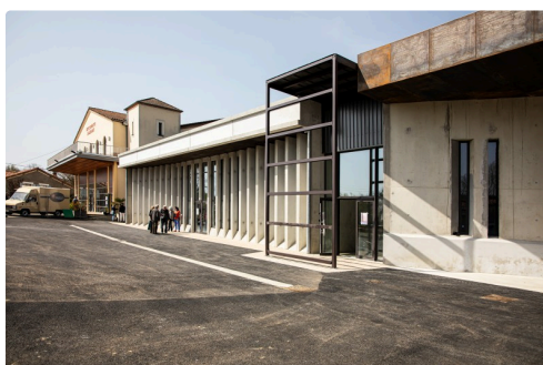
Façade du nouveau chai expérimental
