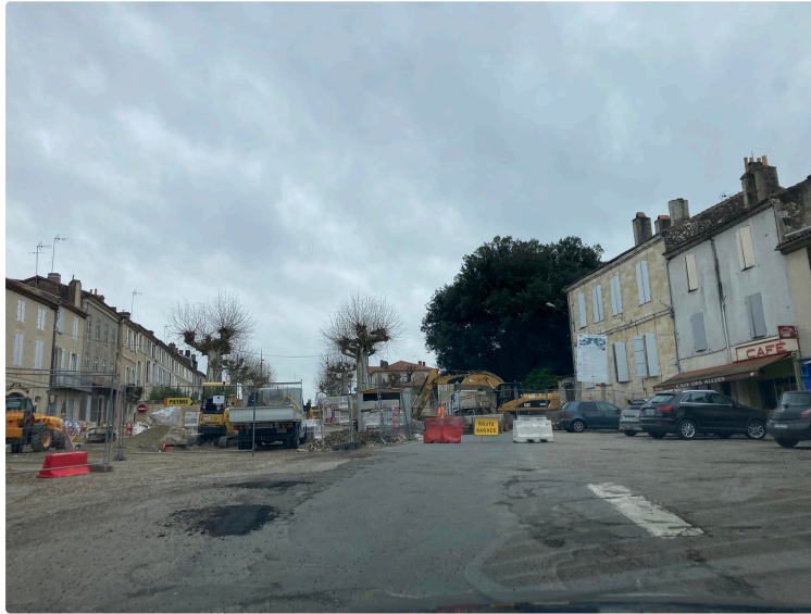
Travaux ; C'est parti et bien parti
