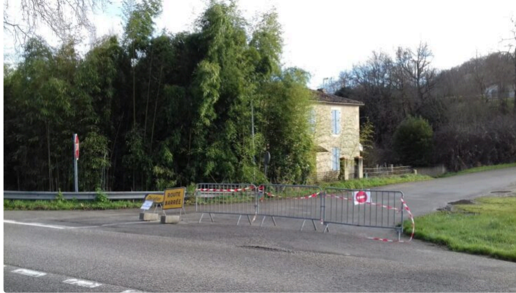
Fermeture de la route du lac pour cause de travaux
