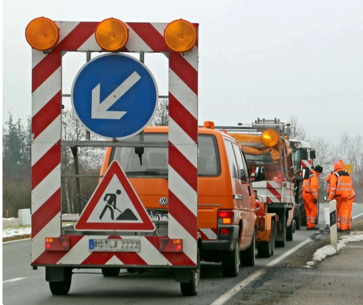
Travaux sur la RD 654 et interruption de la circulation
