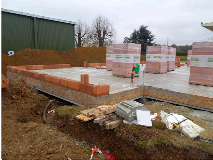
Au stade les travaux avancent
