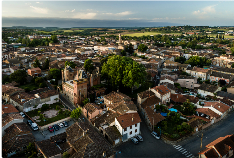
Amélioration du fonctionnement des réseaux d'assainissement
