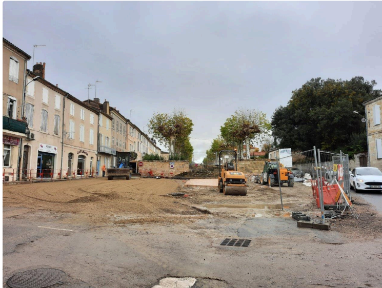
Patience, le chantier touche à sa fin !
