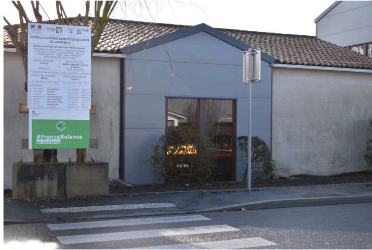
Les travaux au Centre d'incendie et de secours
