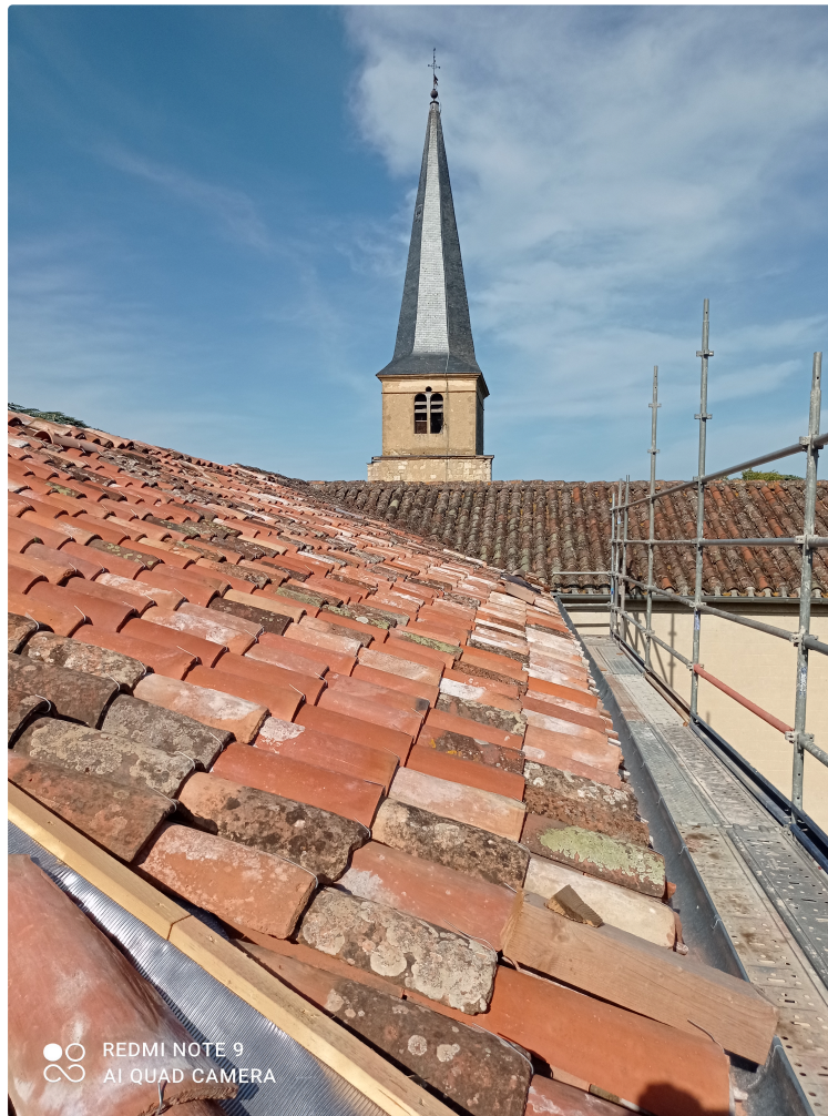
La toiture de la collégiale restaurée
