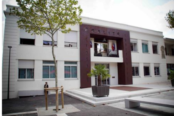
Campagne de restauration de la voirie
