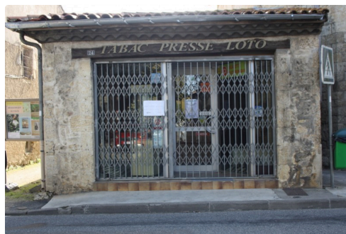
L ancien local qui sera démolì
