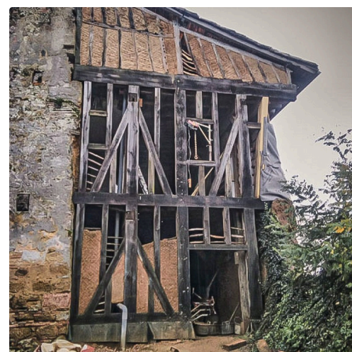
Façade est avant remplacement du torchis (photo Terre crue & pierre)
