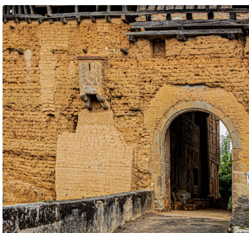
Sous les latrines après les travaux
