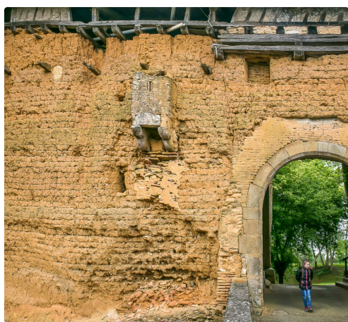
Sous les latrines en 2014 avant les travaux
