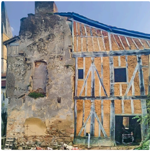
Façade est après remplacement du torchis (photo Terre crue & pierre)
