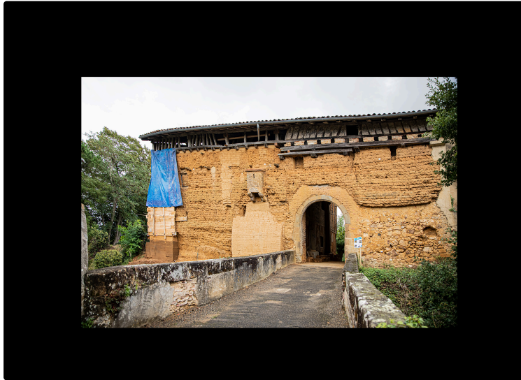
La réfection du Castet de Sainte-Christie-d'Armagnac avance
