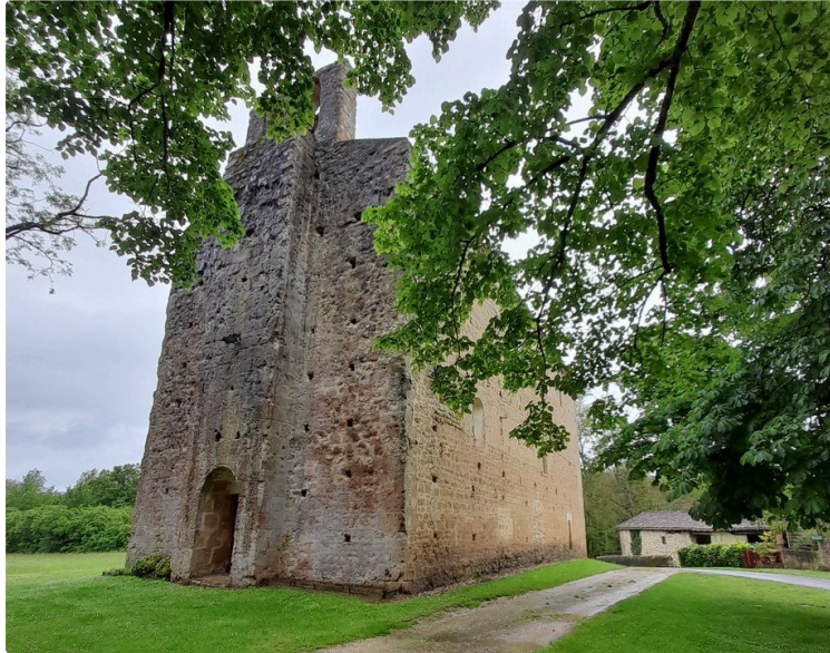
Deux circuits pour les amateurs d'histoire locale et de beaux monuments qui méritent le détour
