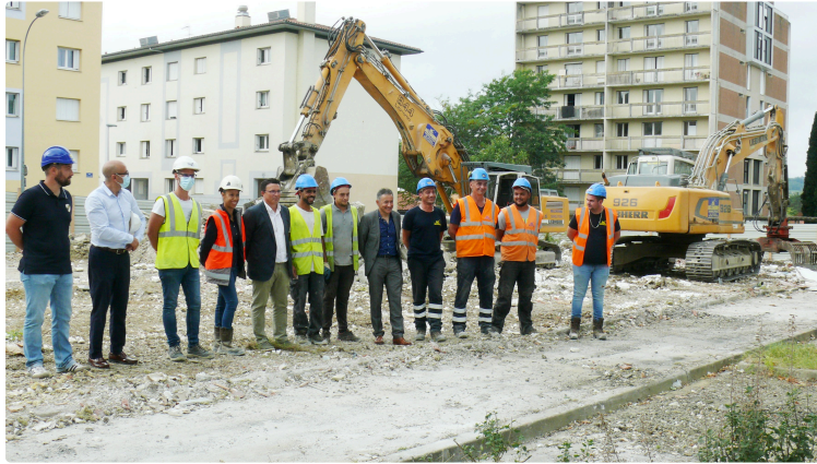
Déconstruction des bâtiments du Garros : Un chantier vertueux selon Bernard Ksaz, président de l'OPH 32
