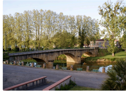
Entrée Est de Plaisance vue du pont et de l'Arros.JPG
