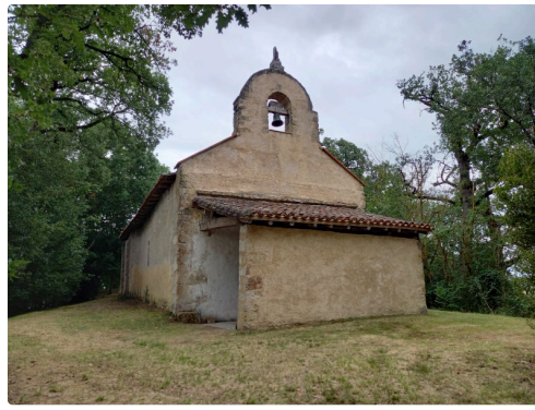
Façade ouest de la chapelle.
