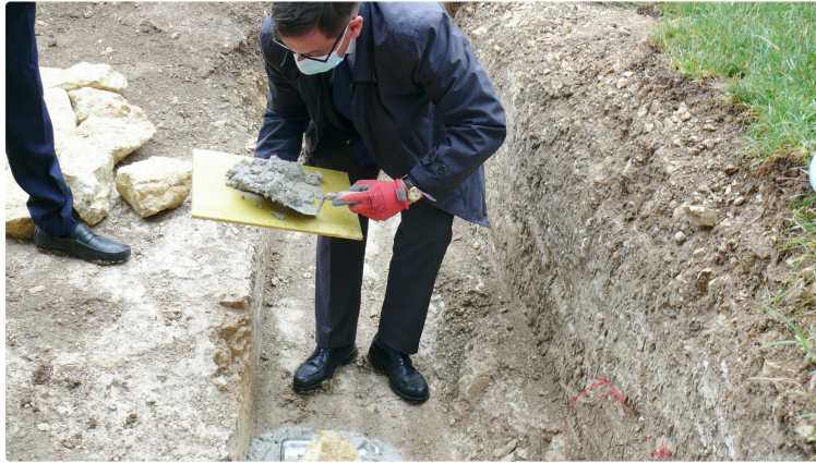
La Petite Pierre : le 4ème chantier de rénovation peut débuter
