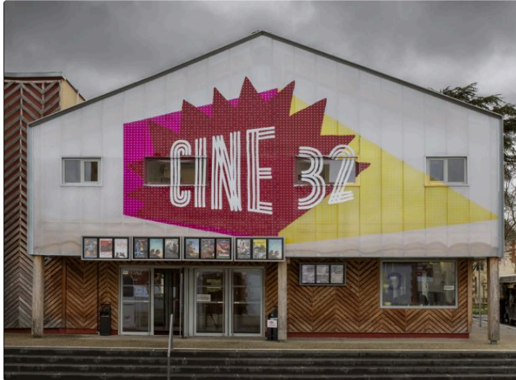
Nouvelles après l'incendie
