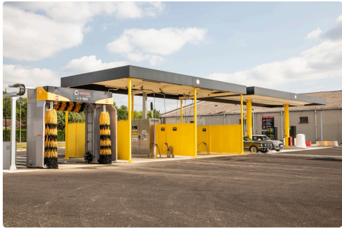
La station-service et sa station de lavage
