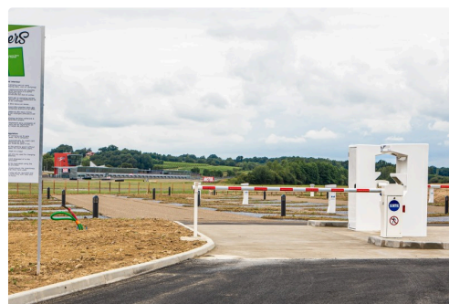
Vue du Parking des Oliviers
