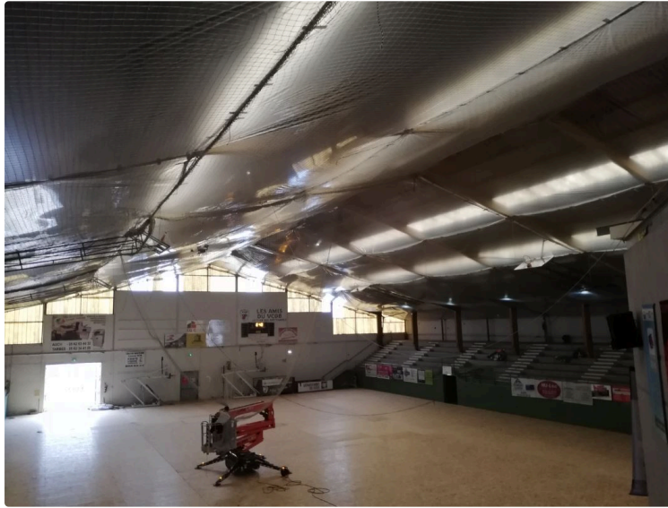
Un chantier impressionnant démarre
