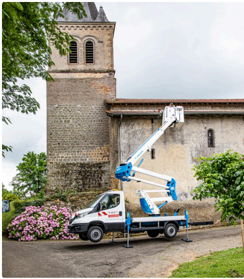
Réfection du toit de l'église de Sainte-Christie
