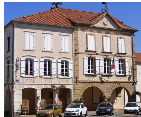
une salle de la Mairie bientôt louée à une association
