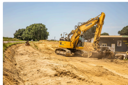
Travail de la pelle à côté de l'entreprise
