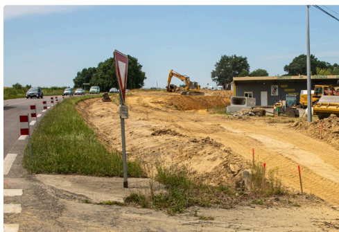
Le haut du chantier
