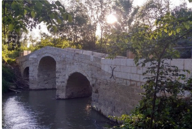
Restauration du pont d'Aurenque
