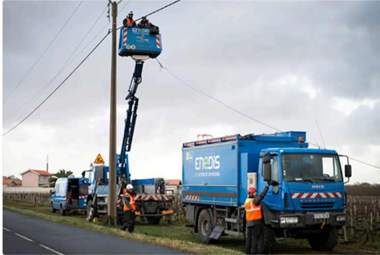
ENEDIS remet à neuf son réseau électrique
