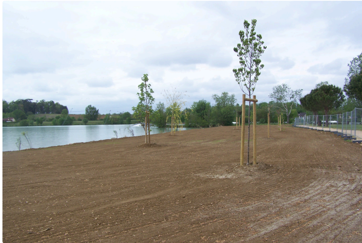
Transformation de la plage en espace verdoyant pour la sécurité du public.
