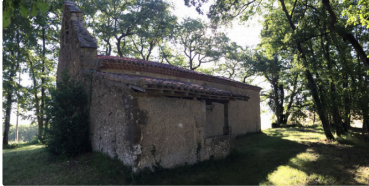
Un nouvel escalier pour la chapelle de LAMANS
