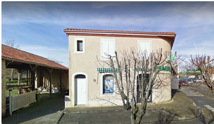
Nouveaux ouvrages à la médiathèque
