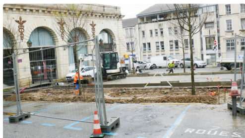
Vue des travaux de plantations et la mise en place des bordures.
