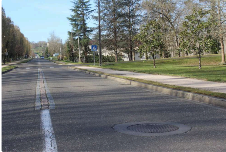
Réfection de chaussée sur la RN 524
