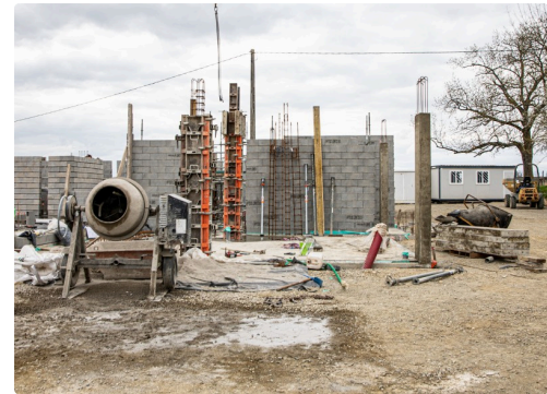
Le chantier le 18 mars
