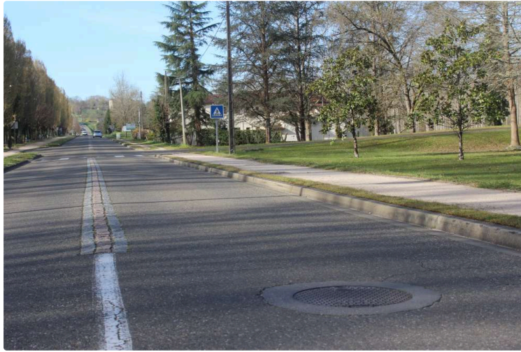
Réfection de chaussée sur la RN 524
