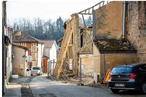
Le chantier n'est pas terminé
