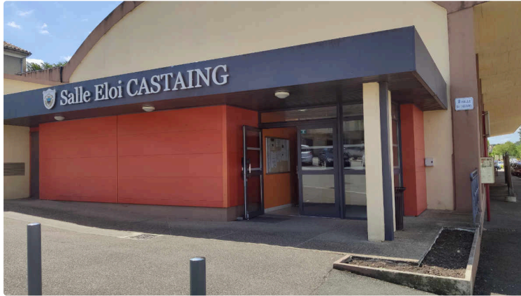
Tout est prêt pour démarrer un drive fermier sur la commune
