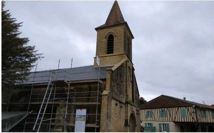
L'église Saint Jacques le Majeur les travaux vont bon train
