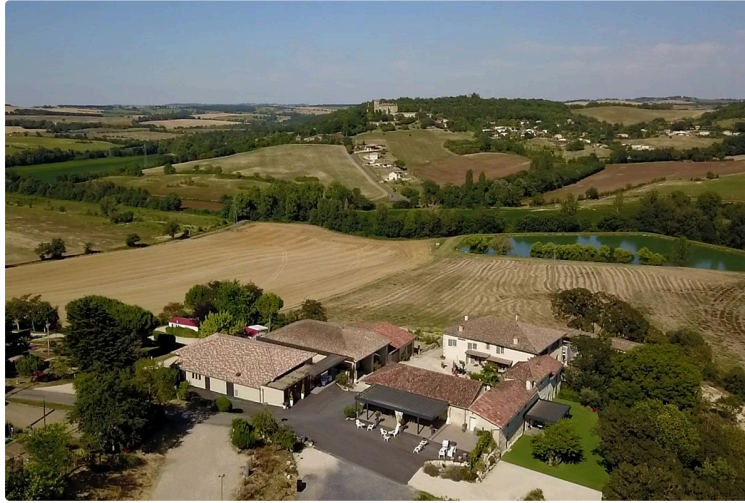
Une nouvelle ZAE de 37 hectares sur l'agglomération !
