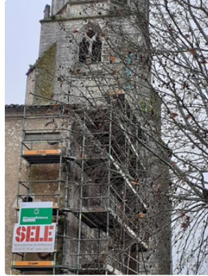
Travaux à l'église de Mauvezin
