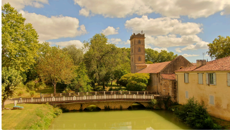
De l'importance d'avoir des ponts routiers en bon état !
