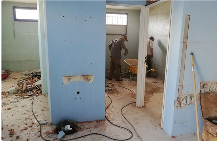
Tennis club : les travaux avancent
